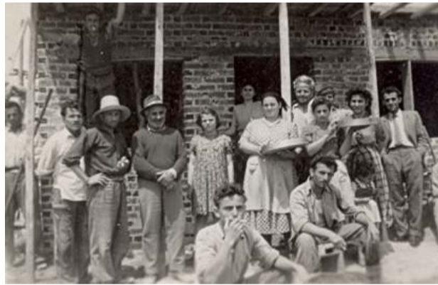
Κατασκευή σπιτιού στην Ν. Τραπεζούντα την δεκαετία του '50
